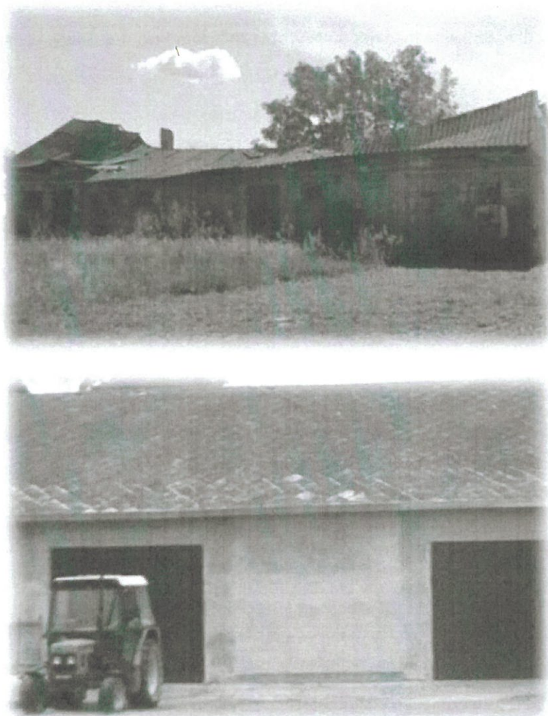
Rysunek 1. Wyroby azbestowo-cementowe: na górze płyty faliste, na dole płyty płaskie (źródło: materiały własne).
